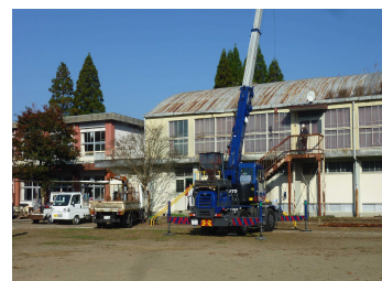
【クレーン操作の様子】
